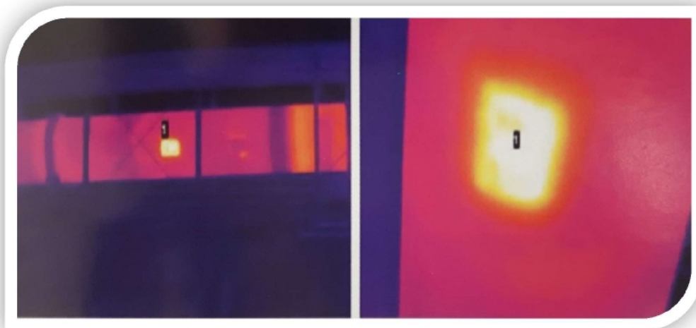
شکل (۵) عکس حرارتی یک کوره‌ی دوار که بخشی از عایق داخلی آن افتاده است
